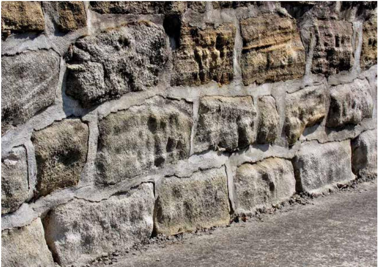
**Figure 37: Incompatible mortar.**
